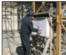
损坏的配电箱
