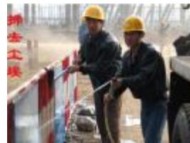
消除施工过程中产生的尘埃
